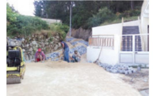
Acesso à Barronda (Remoães) – Depois de instalada uma nova rede de distribuição de água ao domicílio, bem como executadas canalizações relativas à água de rega, foi pavimentado em cubo.
