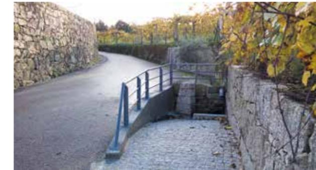
Fontenário da Fonte Nova (Remoães) – Foi executado o arranjo deste fontenário, com instalação de gradeamento de proteção e pavimentação. Na sequência foi, também, beneficiado o Fontenário de Mitreira, através de nova pavimentação.
