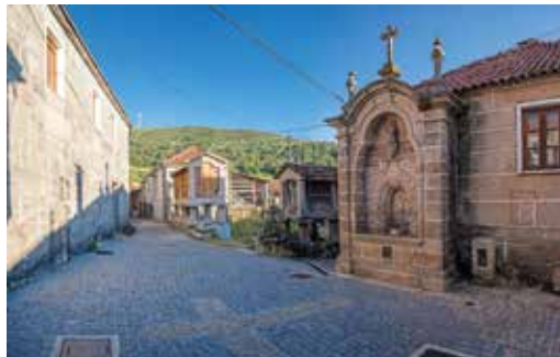
Execução de sarjetas e grelhas para águas pluviais na via pública.
