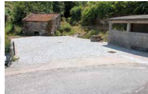
Pavimentação em cubo do largo junto ao moinho da estrela
