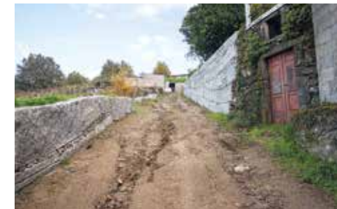
Razas Raposeiras-muro suporte.
