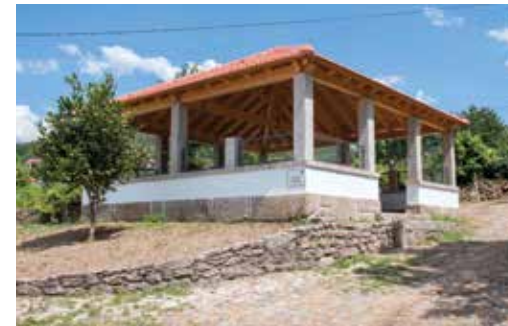
Recuperação do património edificado da freguesia - tanque de lavar de Bairro Pequeno
