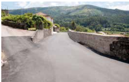
Pavimentação em betuminoso da estrada escola primária - Sarrada
