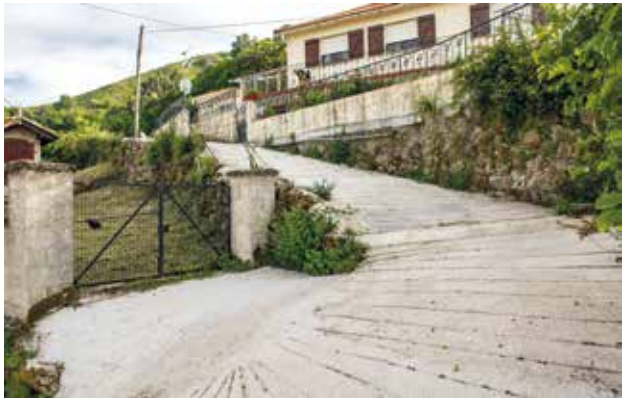
Pavimentação de caminho em Porto Carreiro.
