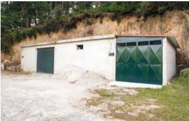
Alargamento da garagem da freguesia.
