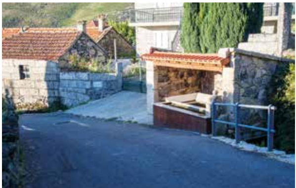
Reabilitação tanque público de Cortegada, Parada do Monte.
