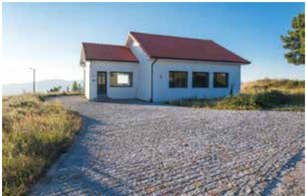
Pavimentação e arranjos exteriores do Centro de Dia de Orjaz, Cubalhão.
