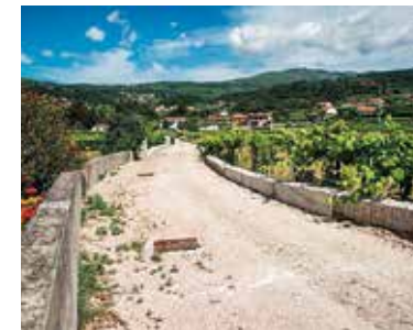
Alargamento e pavimentação do caminho Travessa-Carpinteira.
