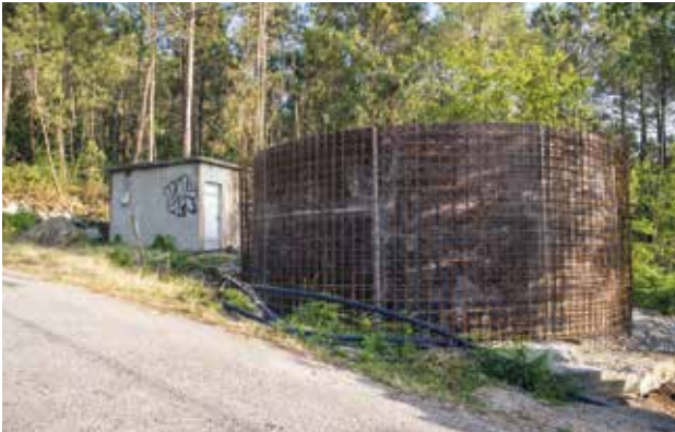
Reservatório de água.
