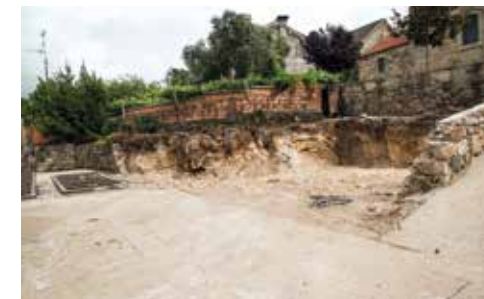
Escavações para construção de Casa Mortuária.
