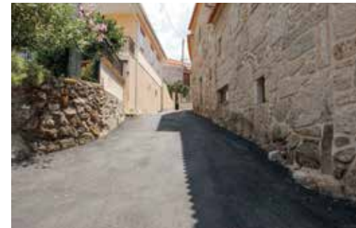
Pavimentação em betuminoso da Travessa da Carreira
