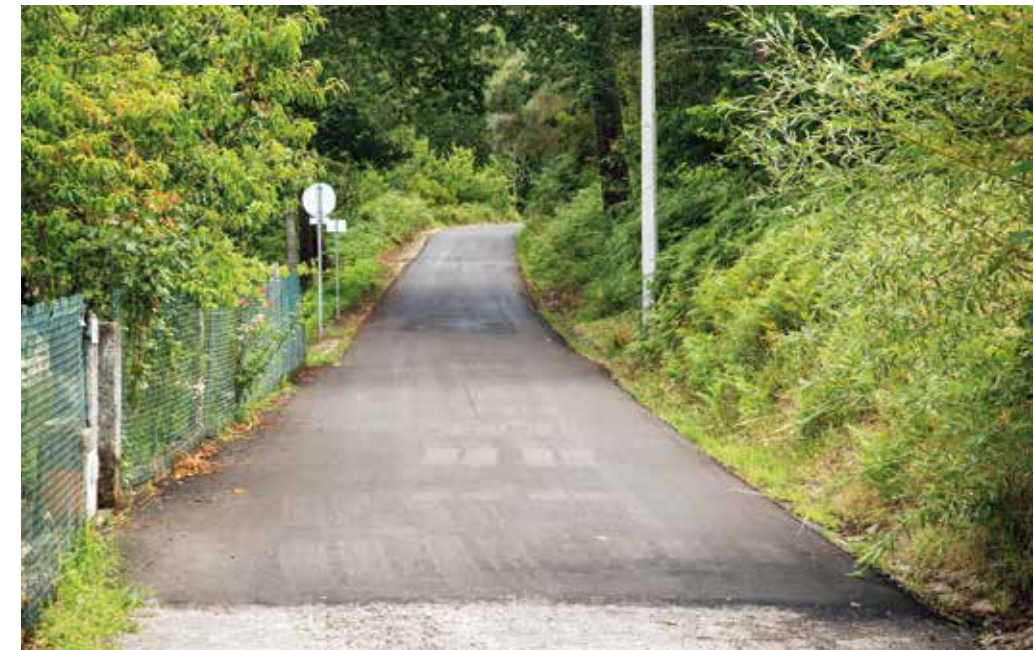
Pavimentação - campo do Souto Roçadas.
