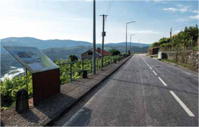
Colocação de guarda corpos no lugar de Assadura
