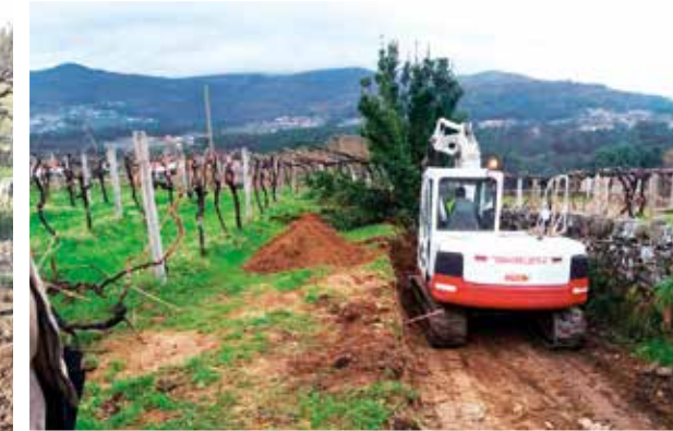
ESCOAMENTO DAS ÁGUAS
