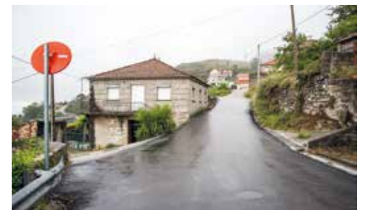
Pavimentação Estrada - Cela
