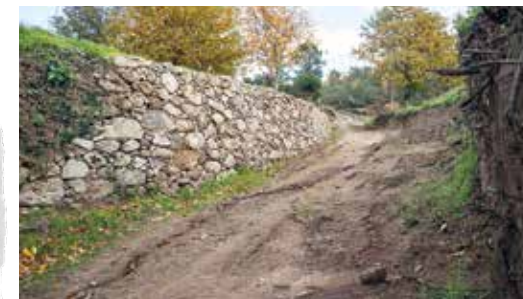
Razas Raposeiras-muro suporte.
