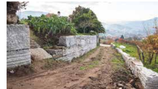
Razas Raposeiras-muro suporte
