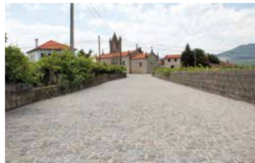
Pavimentação em cubo: ligação estrada do Pomar - Igreja
