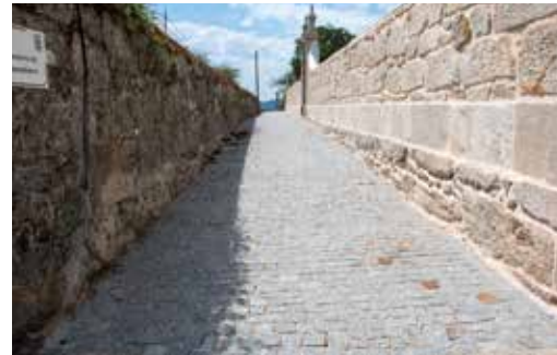
Criação de rampa de acesso ao cemitério e pavimentação em cubo do caminho da Ramalheira
