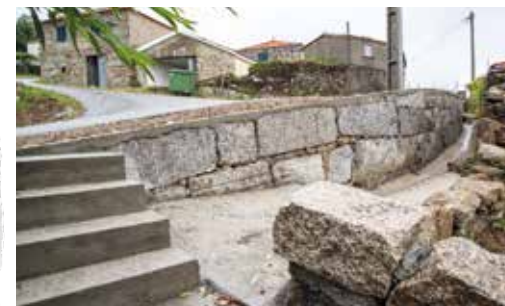
Muro de suporte - Virtelo
