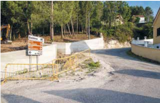
Alargamento no acesso ao Lugar Baldosa.
