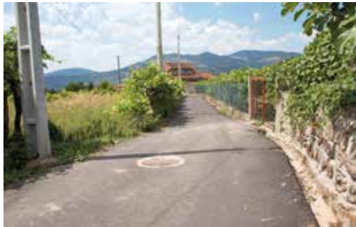
Pavimentação em betuminoso do acesso Telhada - Bairro Pequeno
