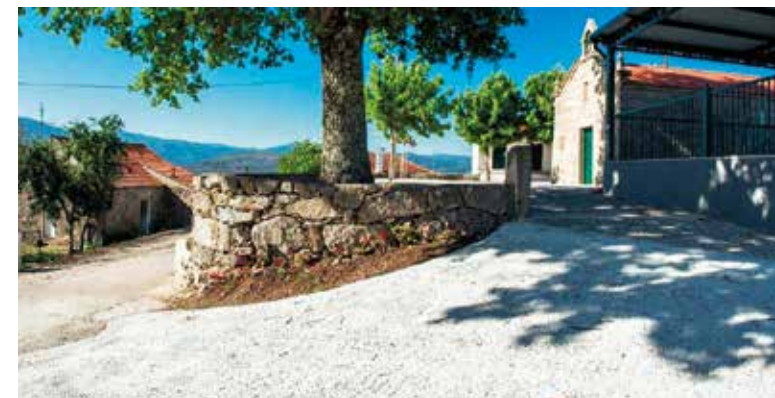
Pavimentação da entrada da Capela de Castros.
