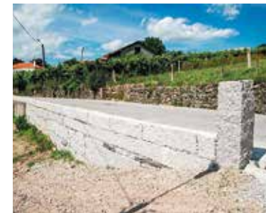
Muro de suporte.
