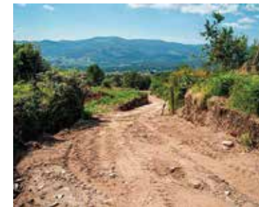
Alargamento do caminho Rasa-Raposeiras.
