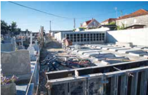
Ampliação cemitério Parada do Monte.
