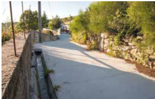
Limpeza e pavimentação de caminho em Cubalhão.
