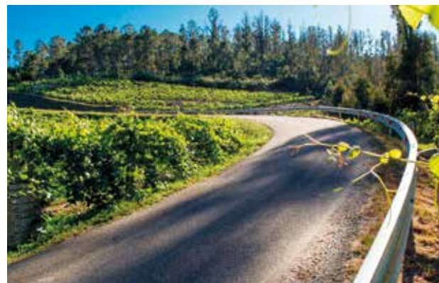
Colocação de rails na estrada Sainde - Pomares.
