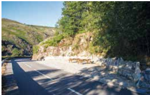
Construção parque de merendas e repouso na minhoteira, Parada do Monte.
