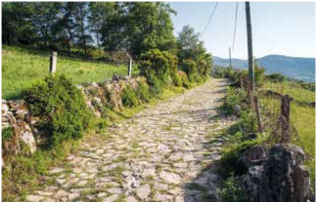
Pavimentação na Branda da Aveleira.
