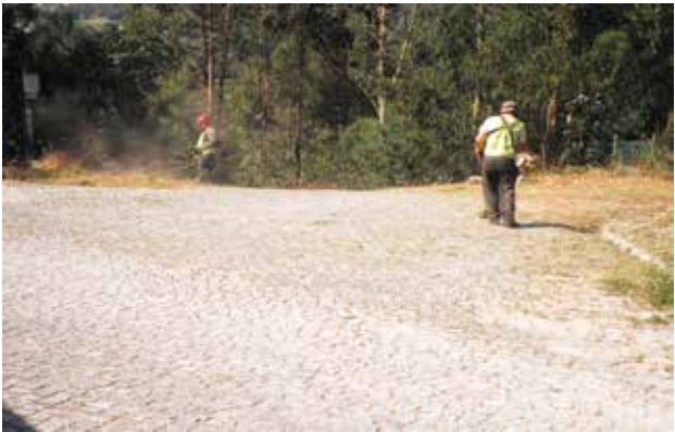
Limpeza de valetas
