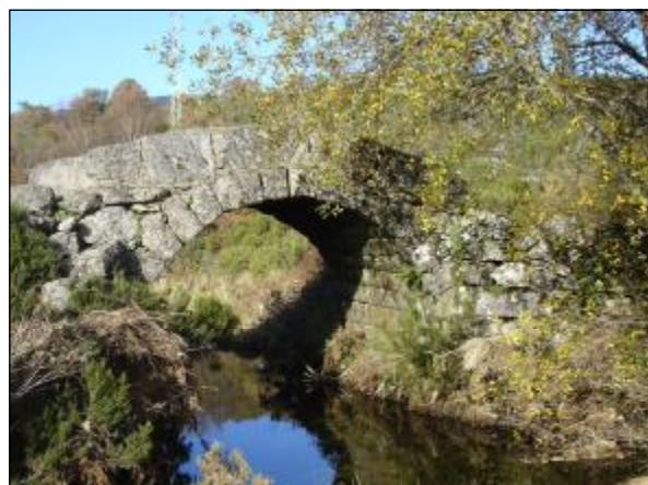
Ponte do Porto Ribeiro
