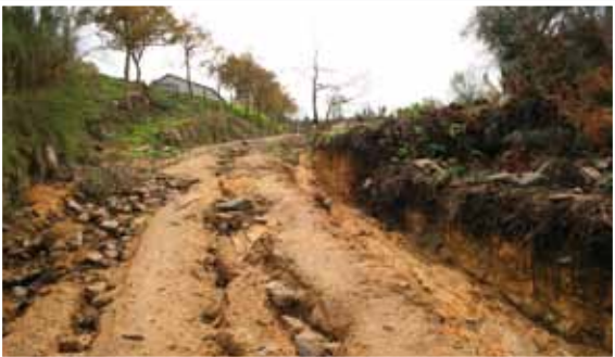
Cubalhã – Após a abertura do caminho entre Portela e Veigas, no Lugar de Cima, decorrem agora os trabalhos de construção dos respectivos muros de suporte
