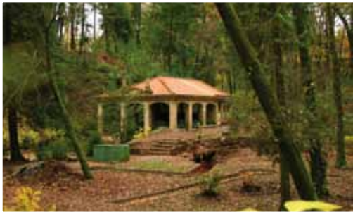
Fonte nova - Procedeu-se à substituição do telhado
