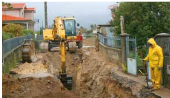
Alvaredo – Continuam a decorrer os trabalhos da 2ª fase de execução da rede, tendo a 3ª e última fase sido já adjudicada
