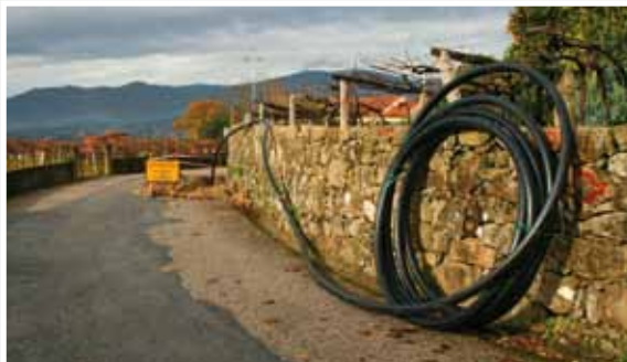
Prado – Está a proceder-se à substituição de troços da rede de abastecimento de água ao domicílio, nas ligações Outeirão/Bouços e Outeirão/Barronda
