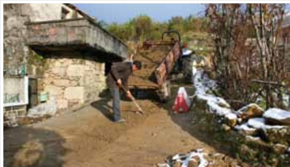
Couso – Está a proceder-se à execução da rede de drenagem do Lugar de Couso
