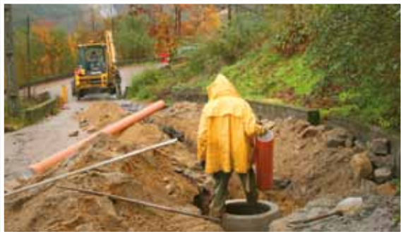
Chaviães – A execução da rede de drenagem da Freguesia encontra-se actualmente a decorrer
