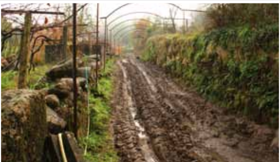
Paços – Está a proceder-se à beneficiação da Ligação entre Govendo de Cima e Esporão (estrada velha), e à construção de muros de suporte
