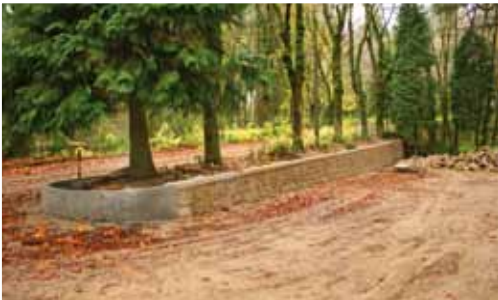
Parque de estacionamento - Foi construído um muro de contenção, a sul do parque de estacionamento, e respectivas escadas de acesso
