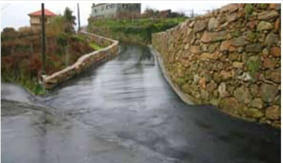
Paderne - Procedeu-se ao alargamento, à construção de muros de suporte e à pavimentação da estrada de Granjão
