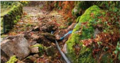
Abast. água (Castro Laboreiro)
