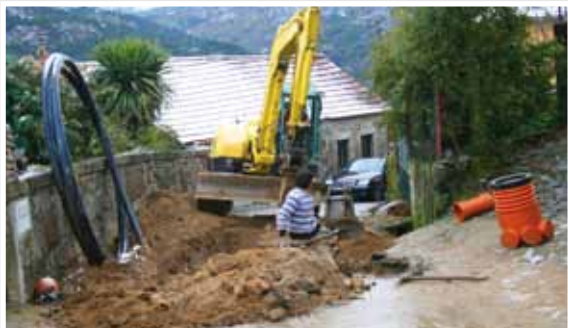
Cristóval – Encontram-se a decorrer os trabalhos de execução da rede de drenagem da Freguesia
