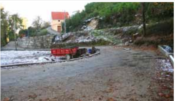
S. Paio – Continuam a decorrer os trabalhos de alargamento e construção de muros no caminho de Carvalha Furada
