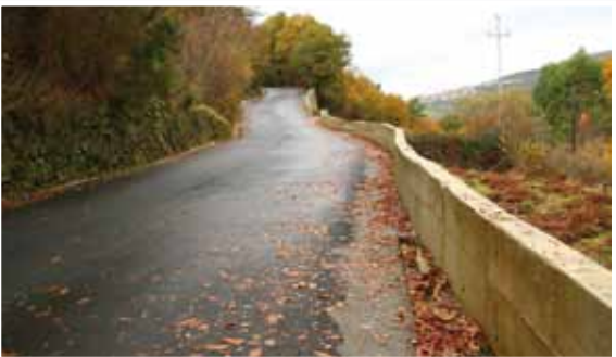
Gave – Procedeu-se ao alargamento, à construção de muros de suporte e à pavimentação do acesso à freguesia, entre Ponte da Cela e Pereiro
