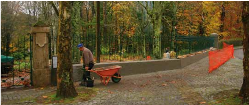
Entrada principal (pedonal) - Muros exteriores em recuperação
