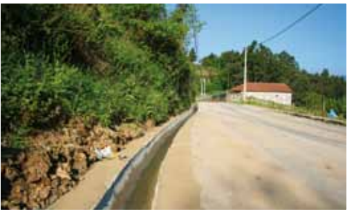
Chaviães (execução de valetas na estrada Portela-Gondufe)
