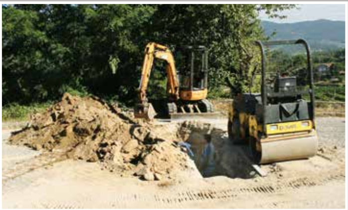
Penso – Executou-se e concluiu-se, em duas fases, o sistema da Freguesia, incluindo a execução da rede e a sua ligação à ETAR já existente na Zona Industrial, e ainda a construção de uma estação elevatória, no Lugar de Paranhão
