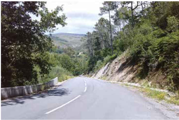
Ligação Ponte de Cela/Pereiro
