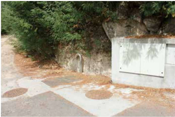
Rede de saneamento
