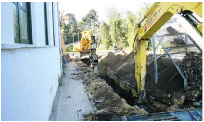
Cristóval – A execução da rede, numa extensão de aproximadamente 11Km, englobou a implantação de 5 estações elevatórias e a construção de uma ETAR
