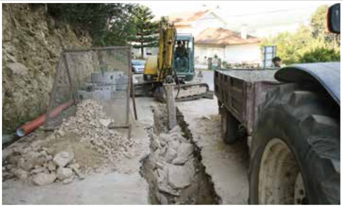
Chaviães – A rede de drenagem foi executada, numa extensão de aproximadamente 10Km, incluindo a implantação de 4 estações elevatórias e a construção de uma ETAR
