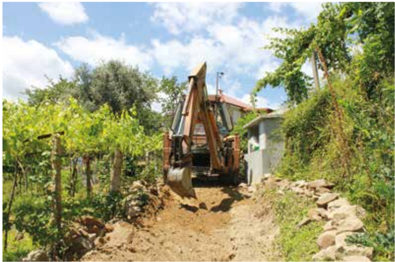
Rede de saneamento - Prado
