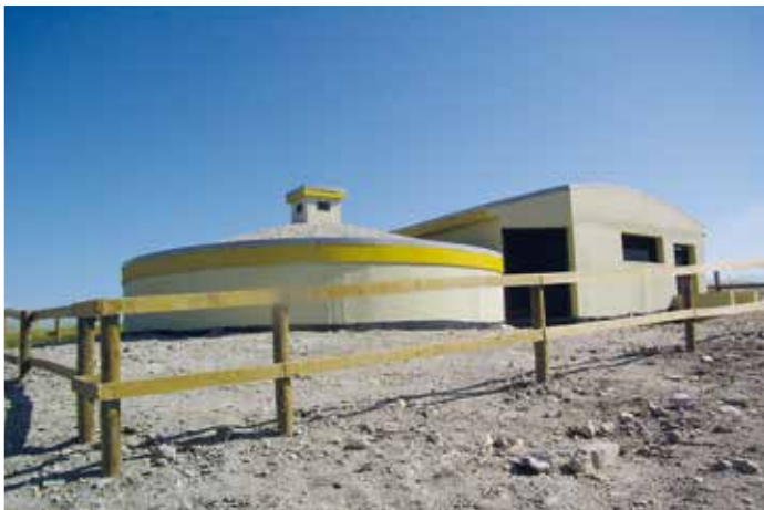
Abastecimento de água
