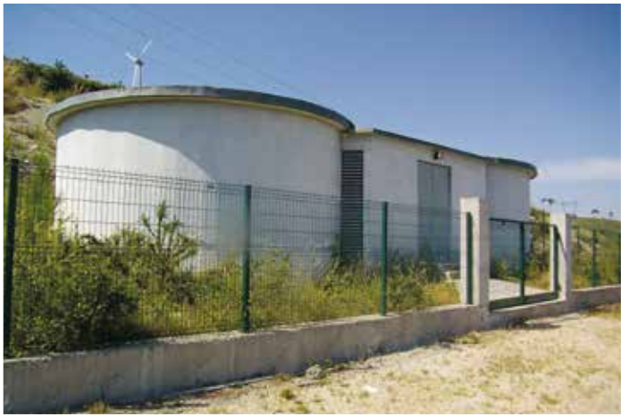
Abastecimento de água
