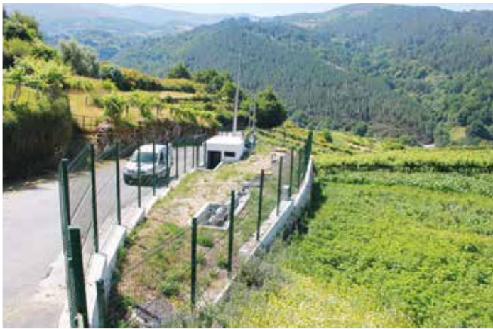
Rede de saneamento - Cela
