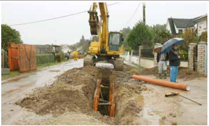
Alvaredo – O sistema foi concluído, através da 2ª e 3ª fases de execução da rede e da sua ligação à ETAR, já existente na Zona Industrial, bem como da instalação de duas estações elevatórias
