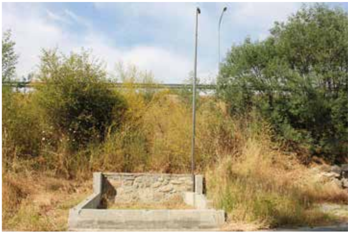
Rede de saneamento
