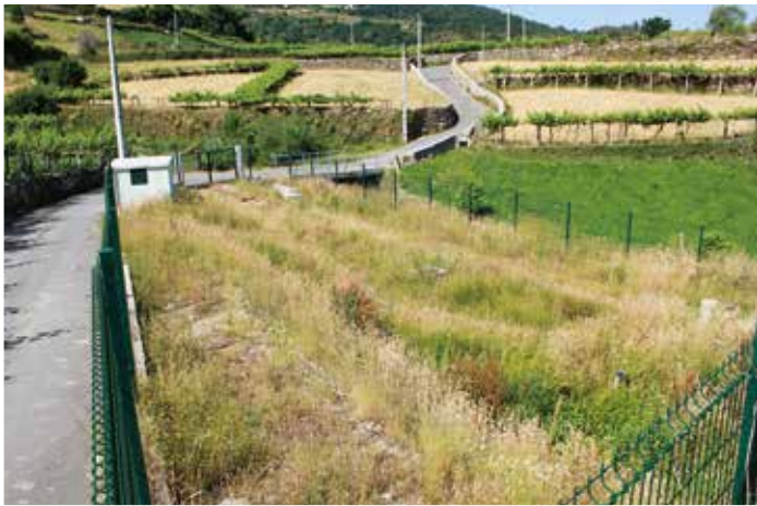
Rede de saneamento
