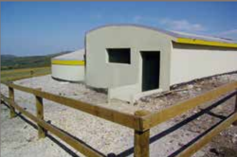
Abastecimento de água
