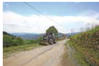
Limpeza de bermas em toda a freguesia
