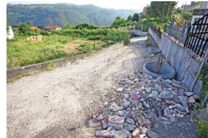
Lameiro - alargamento de caminho e construção de tanque
