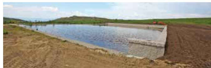
Construção de muro de proteção do ponto de água
