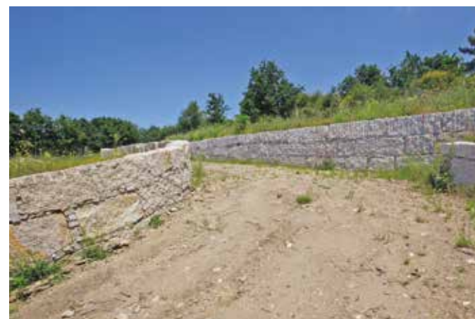
Rasa - Raposeiras - alargamento de caminho e muros de suporte
