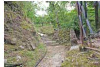
Adedela-Caminho da Canelha. Drenagem de águas bravas
