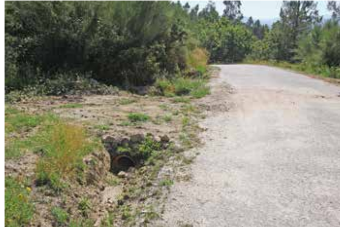
Início das obras nas valetas da estrada Couso-Cela e nas valetas do morado
