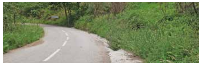
Estrada ligação entre Souto Mendo e Mosteiro - arranjo de valetas
