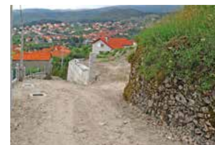
Caminho do Vidoeiro, alargamento e renovação de tubagens de águas pluviais e de rega
