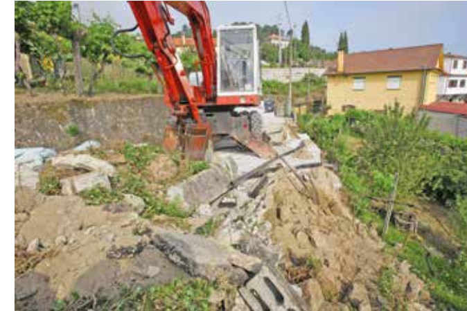
Início de obra do muro de contenção da rua/caminho do Regueiro
