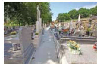
Pavimentação de passeios e drenagem de águas - Alameda do Mosteiro
