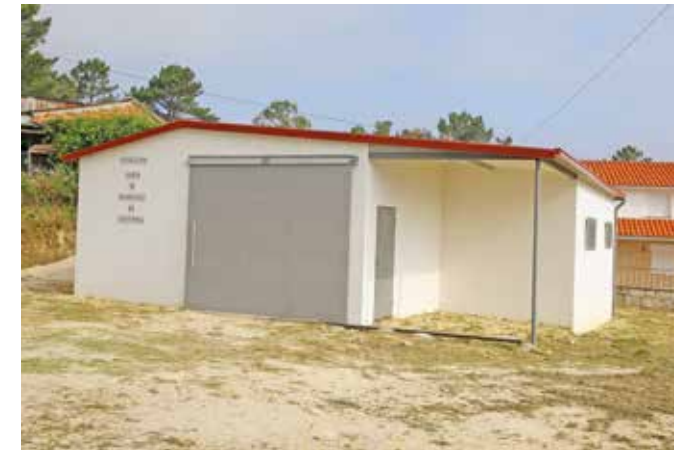
Rua dos Carvalhos-construção exterior de estaleiro, rede, grades e portas
