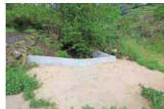
Aqueduto da corga de Porto Carreiro
