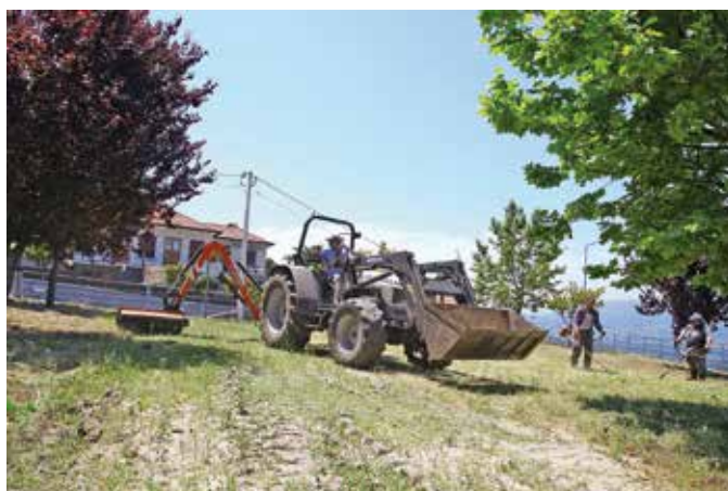
Limpeza de bermas da freguesia
