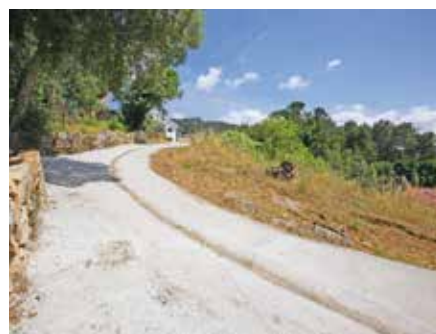
Chaviães – alargamento e pavimentação do caminho da Nogueira
