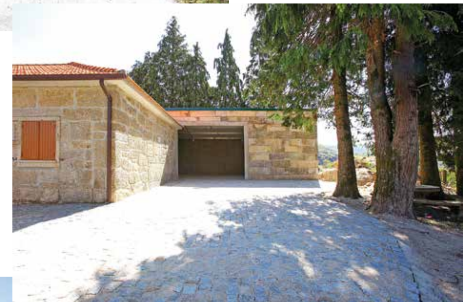
Vila de Castro - acesso e construção de armazém
