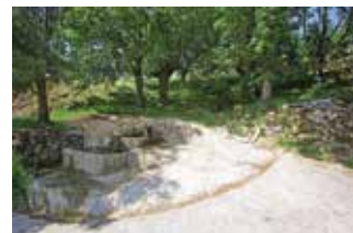
Lugar do Candoso: desmatção de logradouro e demolição de tanque de lavar em ruínas
