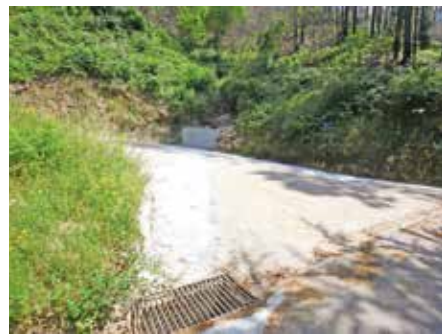
Paços – construção de aqueduto para águas bravas na Sra. de Lurdes
