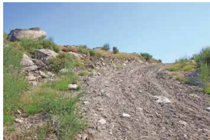
Aplicação de Tout-Venant nos pontos mais afetados do estradão
