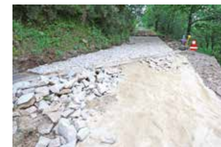
Construção de canal para águas pluviais e repavimentação com calçada portuguesa Mourim
