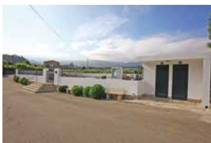
Remoães – construção de casas de banho
