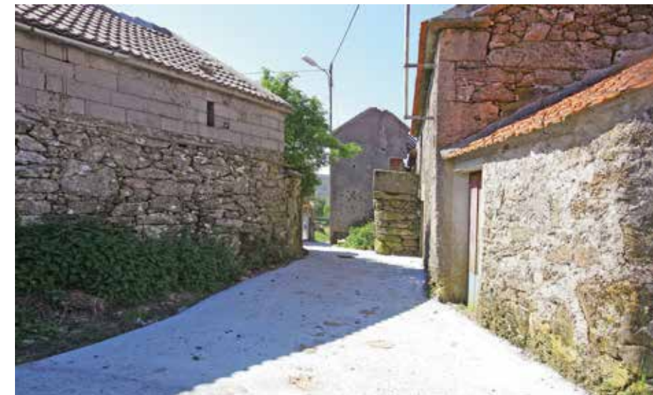
Lugar das Eiras - encanamento da levada de água, alargamento e pavimentação do caminho
