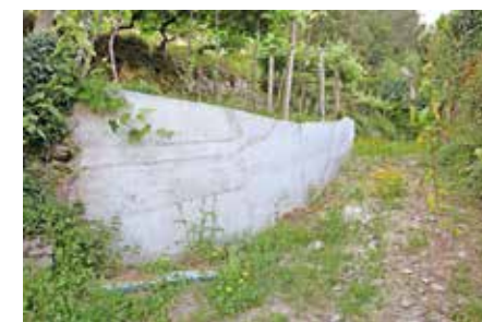
Eiriz-Rebolal: alargamento de caminho e reconstrução de muro
