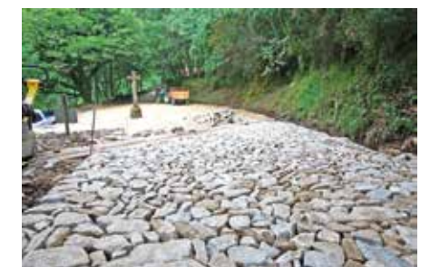
Construção de canal para águas pluviais e repavimentação com calçada portuguesa Mourim
