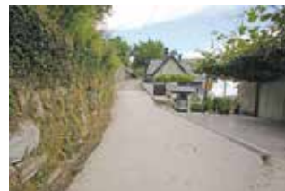
Pavimentação da rua de S.João - Adevelha
