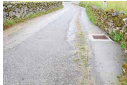
Pomares canalização e alargamento da Rua do Carvalho
