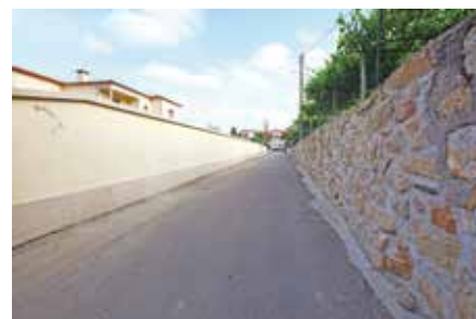
Remoães – limpeza de valetas
