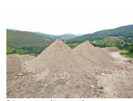
Britagem de resíduos para fazer tout-venant
