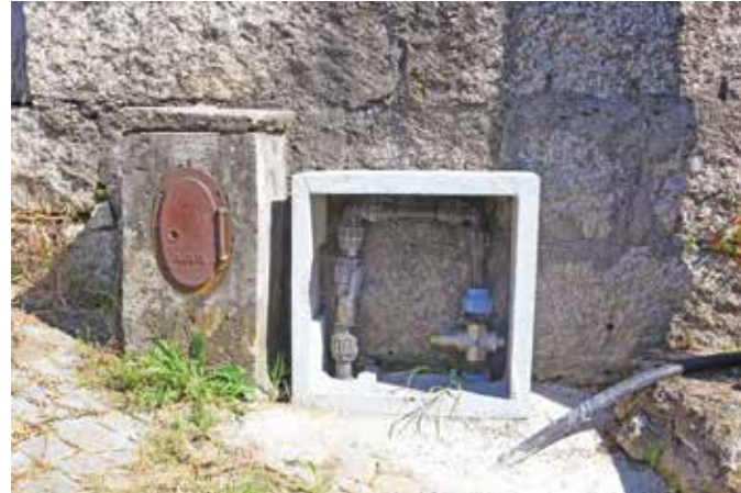
Substituição de cerca de dois mil metros de tubagens antigas e colocação de novos equipamentos na rede de água
