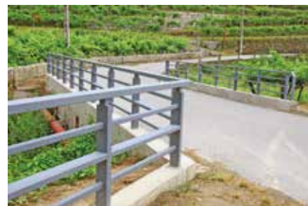
Gradeamento de proteção da Ponte da Aldeia
