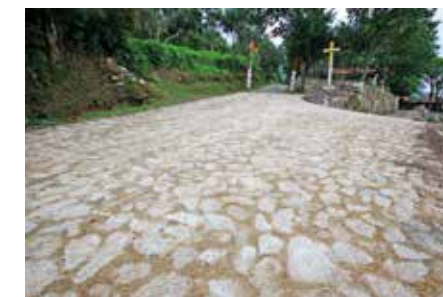
Pavimentação do Caminho do Mourim
