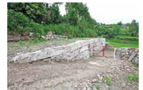
Reconstrução de muro de suporte de caminho
