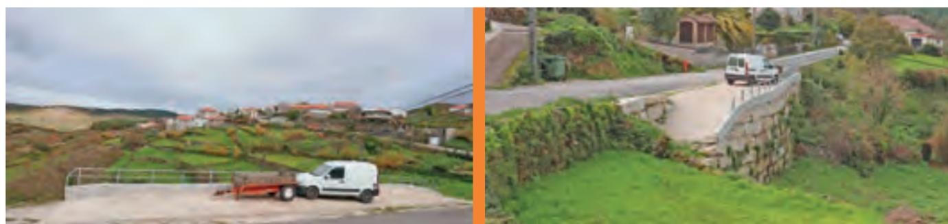
Construção de muro de suporte de estrada, e aproveitamento para parque de estacionamento
