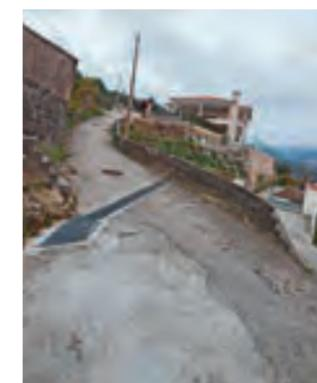
Obras de beneficiação de condutas de águas pluviais, incluindo colocação e fixação de grelhas metálicas, valetas em cimento, travessias e aquedutos no Lugar da Cela
