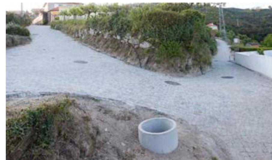
Pavimentação do caminho das poças do pio, incluindo a colocação de novas tubagens de água pública e canalização de águas bravas e de regadio
