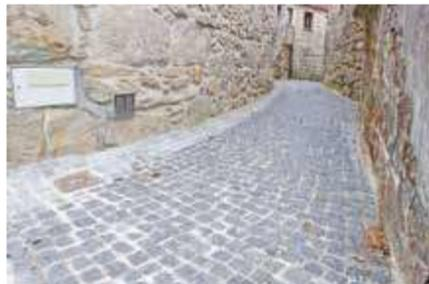
Durante o primeiro trimestre do ano foi beneficiado o acesso à Eira das Mós. Foi levantado todo o cimento que se encontrava cheio de buracos e repavimentado todo o troço em cubo com junta de cimento.
