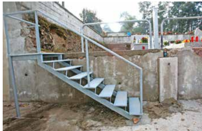
Construção de escadas.
