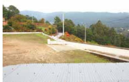
Limpeza de terreno da futura casa mortuária.
