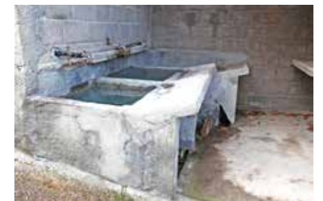
Beneficiação de tanque em Lages-Remoães.
