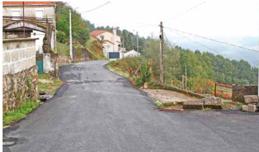
Pavimentação da estrada da Baldosa
