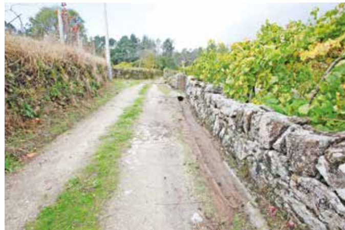
Caminho da Troia - Limpeza do caminho e do rego de escoamento de águas pluviais.
