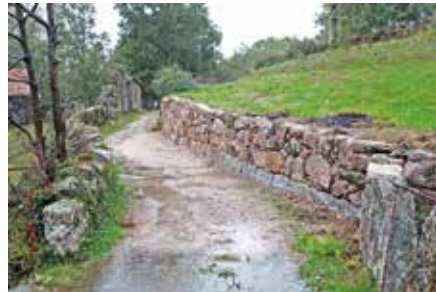
Alargamento e construção de muro no Lugar da Ameijoeira.
