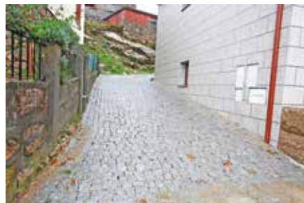
Pavimentação na Vila.
