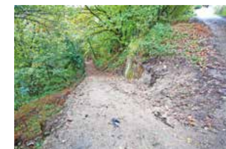
Conclusão dos trabalhos de pavimentação da Estrada Souto Mendo de Cima- Adedela.
