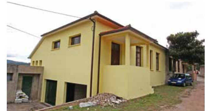
Pintura exterior do edifício da Junta.
