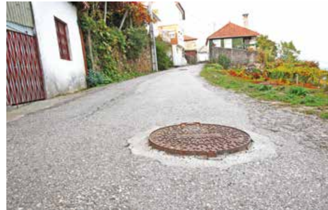
Está em curso a pavimentação Campo de Souto ao cemitério.
