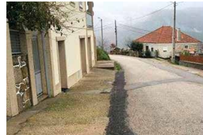
Manutenção e melhoramento em vários pontos rodoviários.
