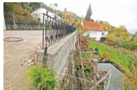
Reconstrução do muro em Campo de Souto.
