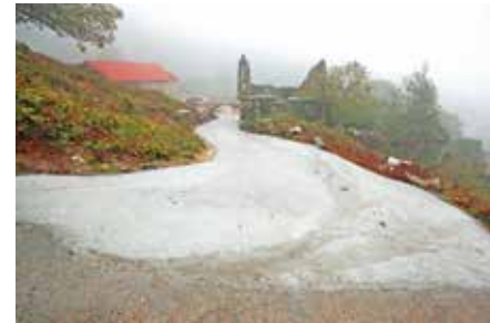
Alargamento e pavimentação no Lugar de Carvalho.
