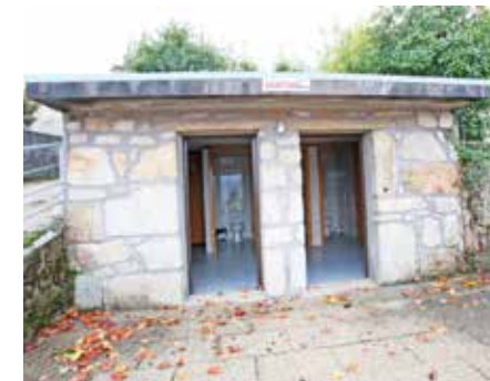
Obras nas casas de banho públicas.
