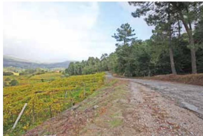
Lugar do Barbeiro, Montarão, Rego, Covelo e Granja. - Limpeza de valetas e taludes.
