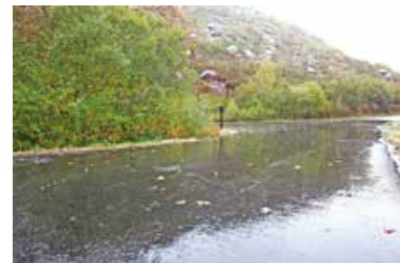
Reposição de 1 km de tapete na Estrada do Ribeirinho.
