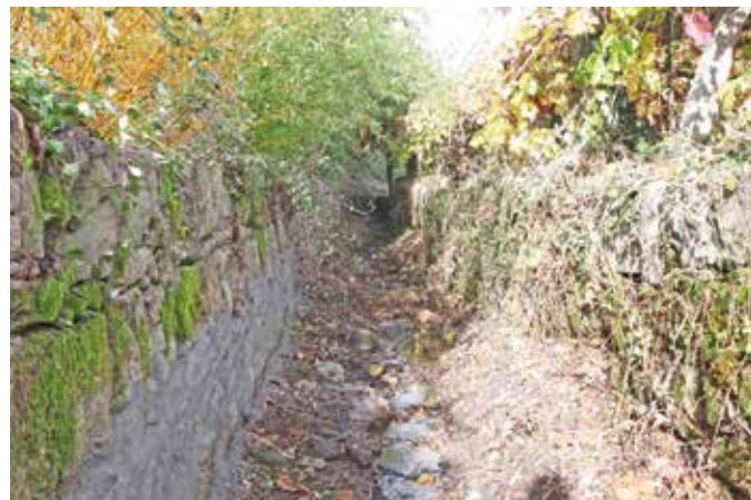
Padreiro - Limpeza da Corga e melhoramento dos muros.
