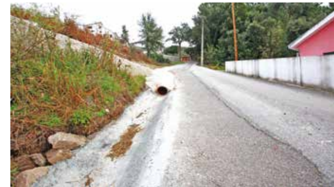
Construção de valetas e canalização de águas pluviais no Lugar Nogueira-Outeiro.
