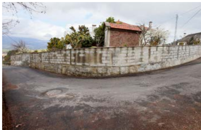
São Paio | Pavimentação em Barata
